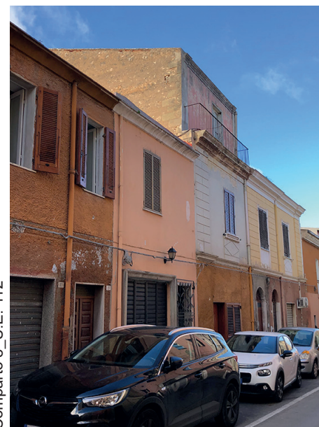
Palazzotti, frutto dell'evoluzione della casa elementare del Nord, trattati con intonaco liscio nella facciata principale e con la tecnica "raso pietra" in quella laterale.
