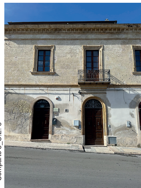
Unità edilizia trattata con intonaco liscio nel piano terra e pietra "a vista" in trovanti regolari nel piano nobile
