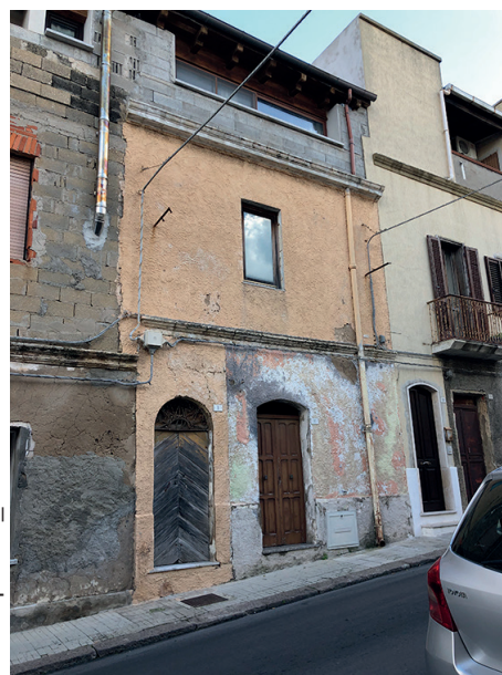
Unità edilizia trattata con intonaco rustico (l'ultimo livello di piano è una superfetazione successiva)
