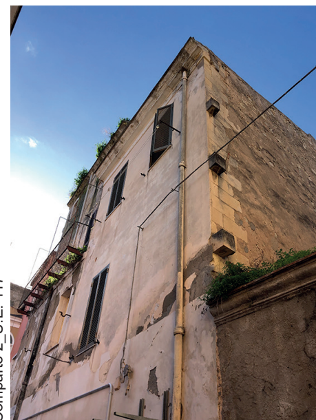
Palazzotti, frutto dell'evoluzione della casa elementare del Nord, trattati con intonaco liscio nella facciata principale e con la tecnica "raso pietra" in quella laterale.
