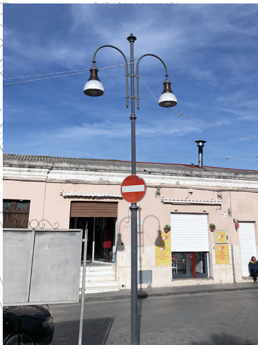
Soluzione con cima pastorale e con doppio corpo illuminante a sezione circolare, illuminazione LED, posizionato su palo
