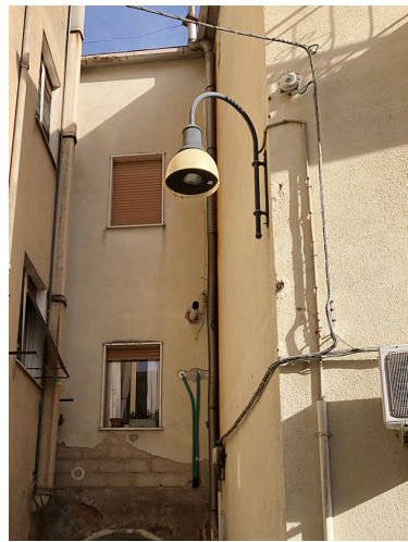
Soluzione con cima pastorale e corpo illuminante a sezione circolare, illuminazione LED, posizionato su mensola a muro
