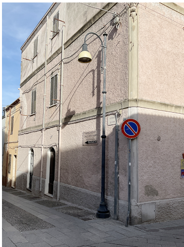
Soluzione con cima pastorale e corpo illuminante a sezione circolare, illuminazione LED, posizionato su palo
